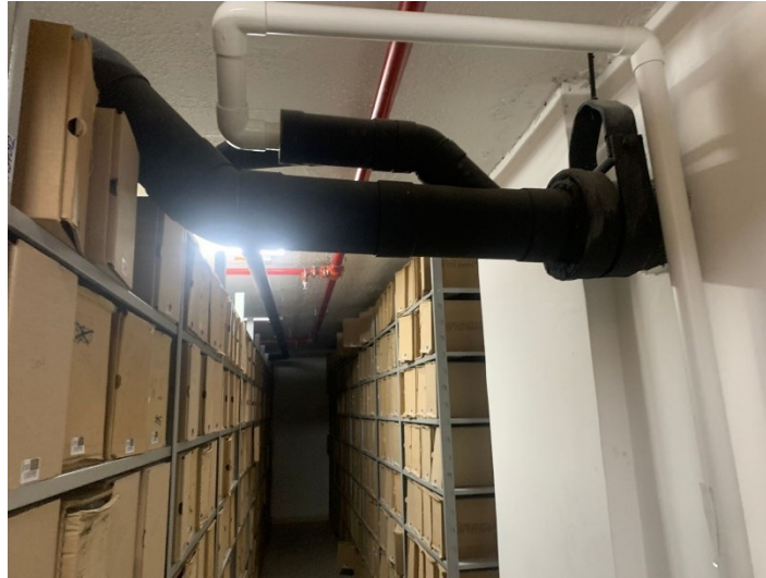
Ilustración 13 Detalle de la tubería y su proximidad con el material documental. Fuente propia
