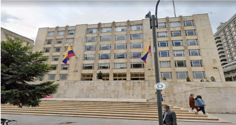
Ilustración 12 Detalle Edificio Murillo Toro - Fuente propia
